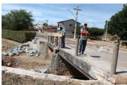
Reforço na estrutura da ponte sobre o Baco-Pari
